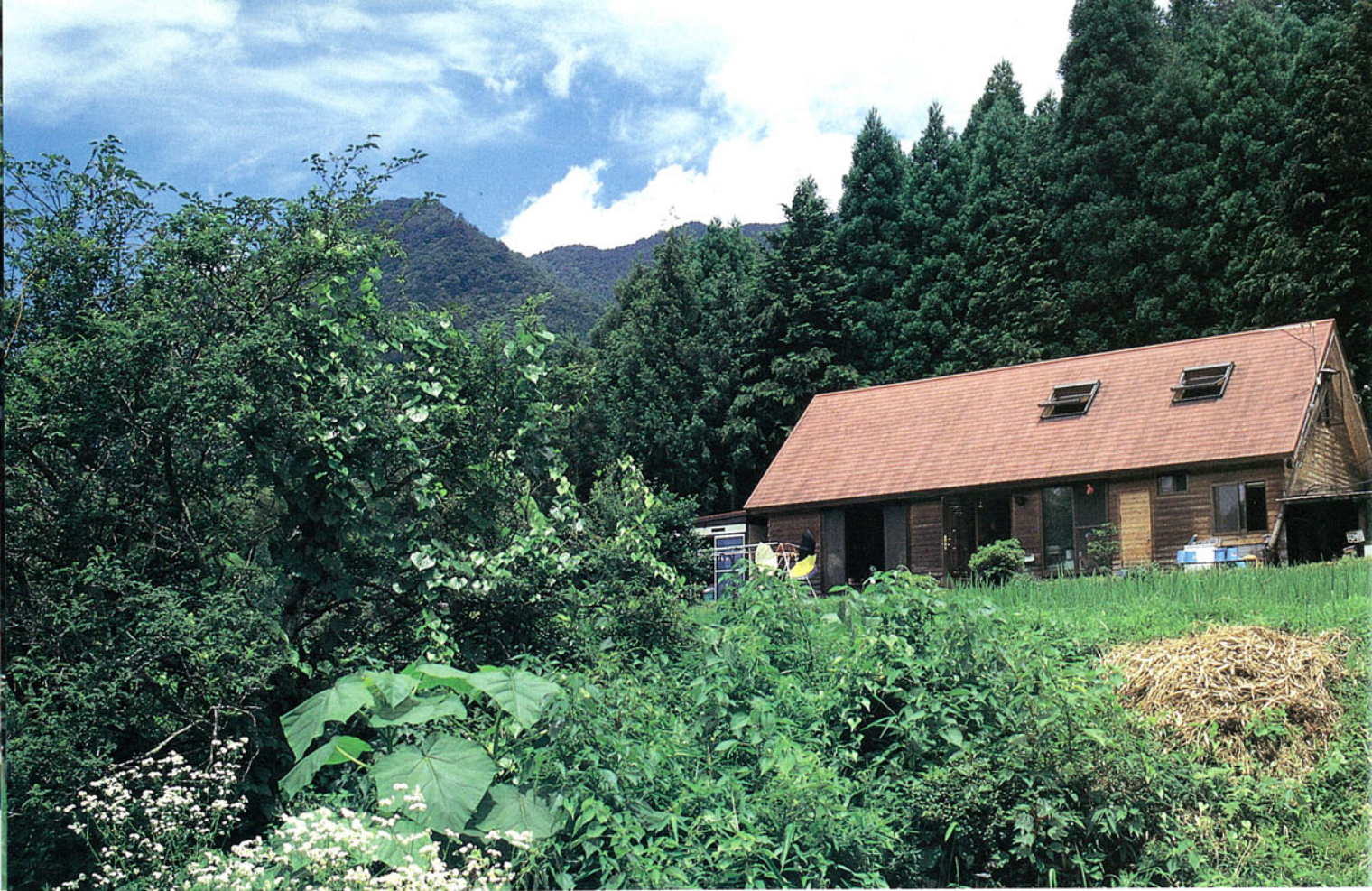
小 高い丘の上に建つ今井家は、基礎からのセルフビルド。一家総動員で8カ月かかった。
